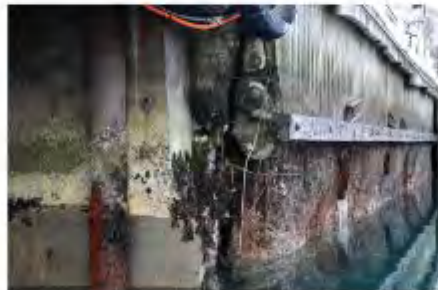
Figur 2-12: Betongveggen skadet og grovnett med Kai 11. Et forankringssteg med påmontert UHF-antenne har øst i lagene på utsk.
