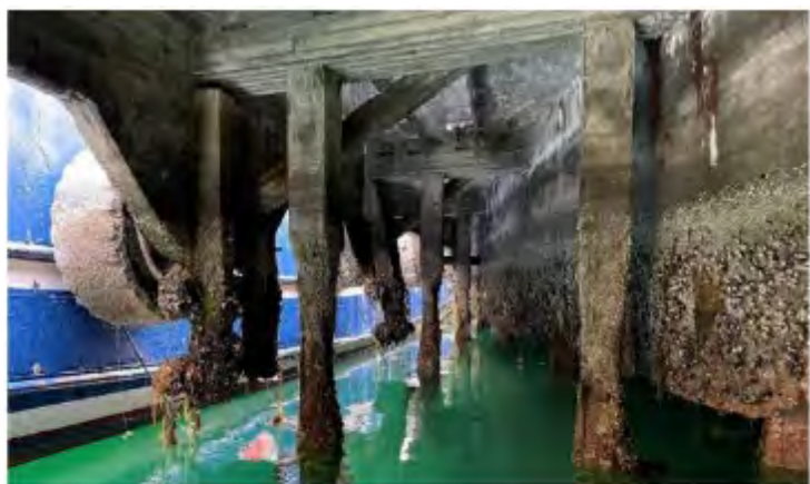
Figur 4 Eroderte piler
