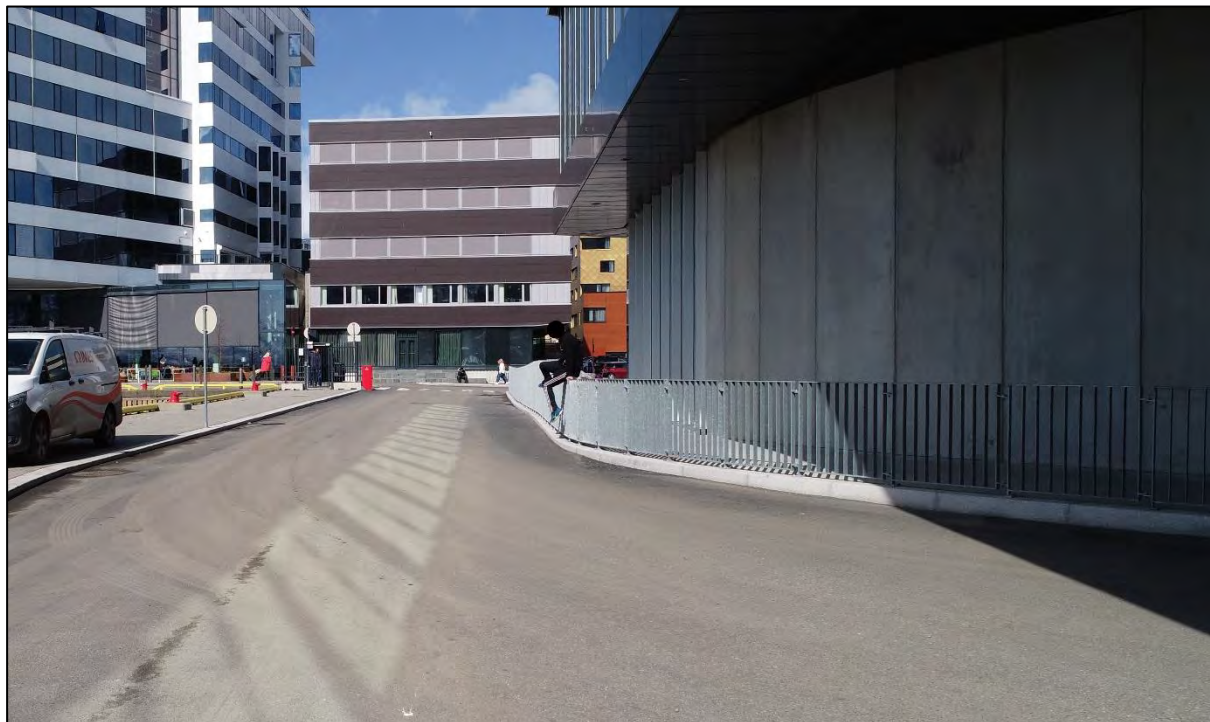
Figur 11 Fotgjenger hopper over ledegjerdet like om svingen fra utkjørselen til bussterminalen (foto: Asplan Viak)
