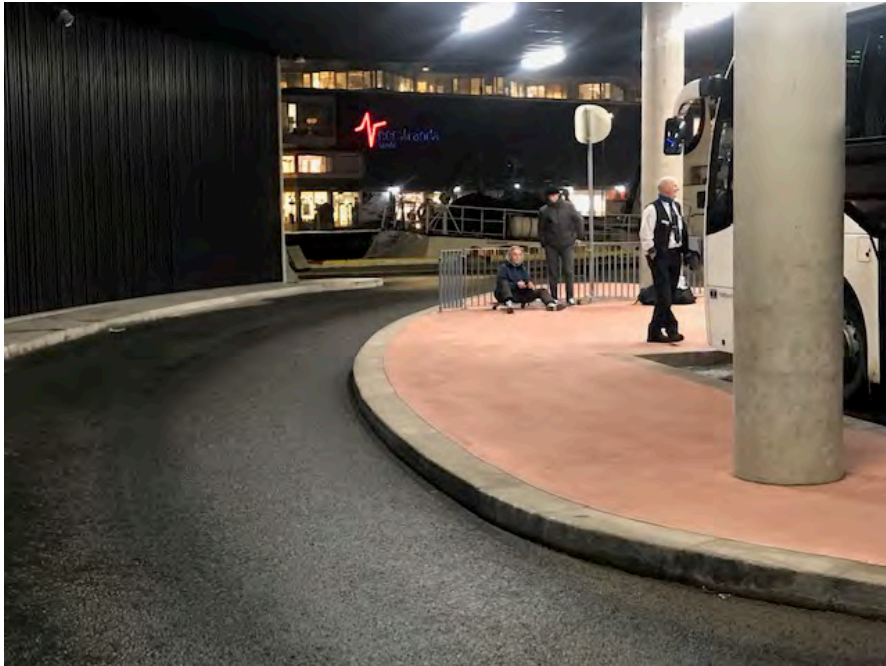
Figur 21 Beskjæring/innsnevring av perrong vil gi økt handlingsrom for buss ved utkjøring fra terminal
