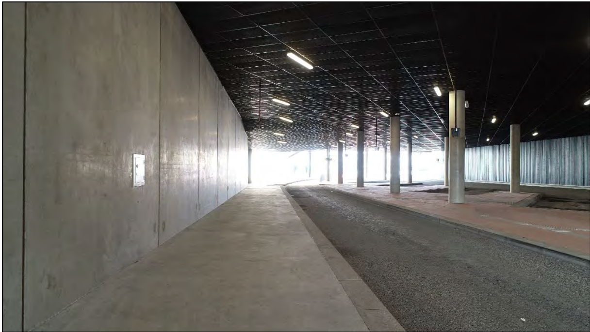
Figur 18 Innløp for ølpumping til restaurant montert på vegg i sørenden av plattform 8 (foto: Asplan Viak)
