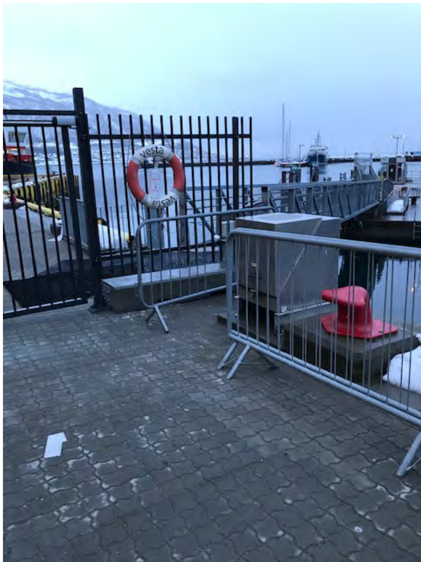
Figur 31 Bunkringssted fra tankbil til hurtigbåtene
