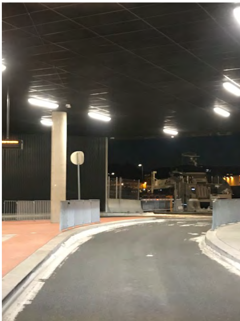
Figur 15 Utforming av perrong, som gir begrenset handlingsrom for buss. Enden av perrong nyttes ikke til noe og er unødvendig.
