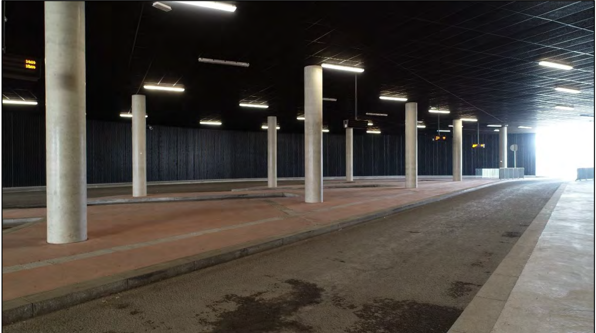
Figur 17 Fysisk ledegjerde er opparbeidet kun i nord- og sørendene av plattform 1-7 (foto: Asplan Viak)
