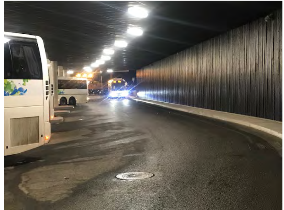
Figur 20 Mørk vegg bakk bussene. Bør males lys for bedre sikt og kontrast ved rygging.
